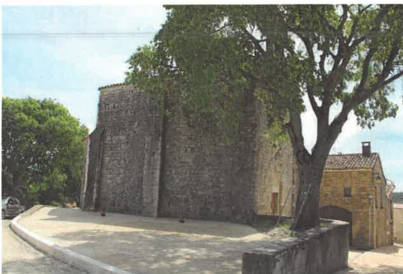
Figure 41 : L'église de Domessargues - Mai 2021 - T&P
