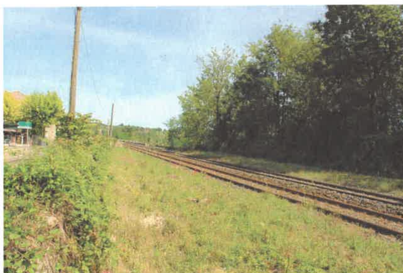
Figure 37 : La voie ferrée au pont de Ners - Mai 2021 - T&P
