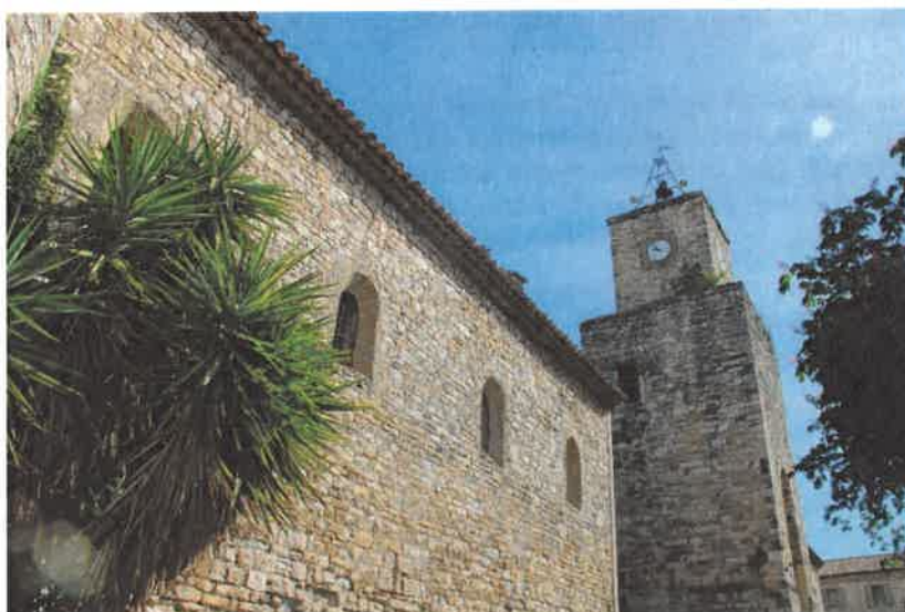
Figure 42 : L'enceinte urbaine de Brignon - Mai 2021 - T&P
