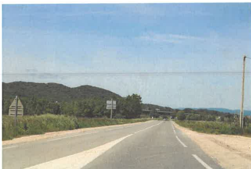
Figure 36 : La route N106 franchissant la route D936 - Mai 2021 - T&P
