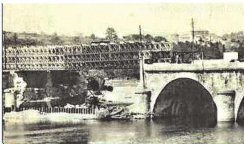
Figure 78 : Le pont de Ners après la crue de 1958 (source : espeluques.over-blog.com)
