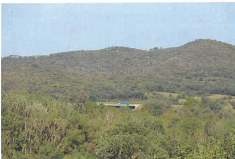
Figure 19 : La route N106 en remblai - Mai 2021 - T&P
