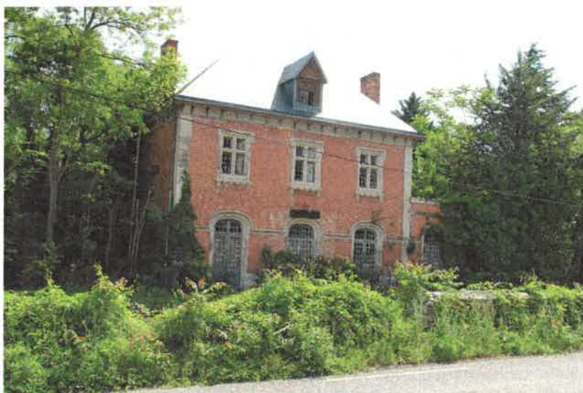
Figure 40 : L'ancienne gare de Ners - Mai 2021 - T&P
