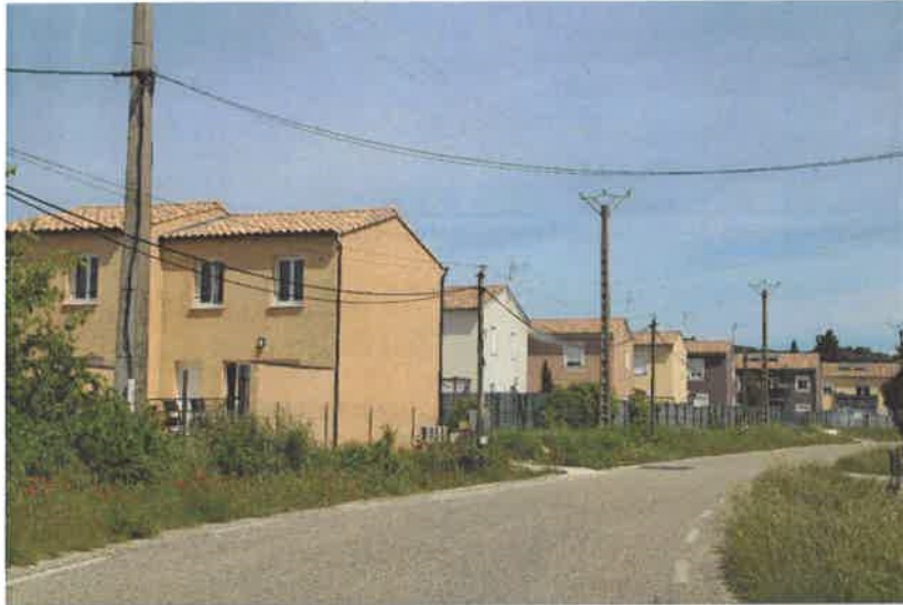
Figure 80 : Les extensions urbaines à Domessargues - Mai 2021 - T&P
